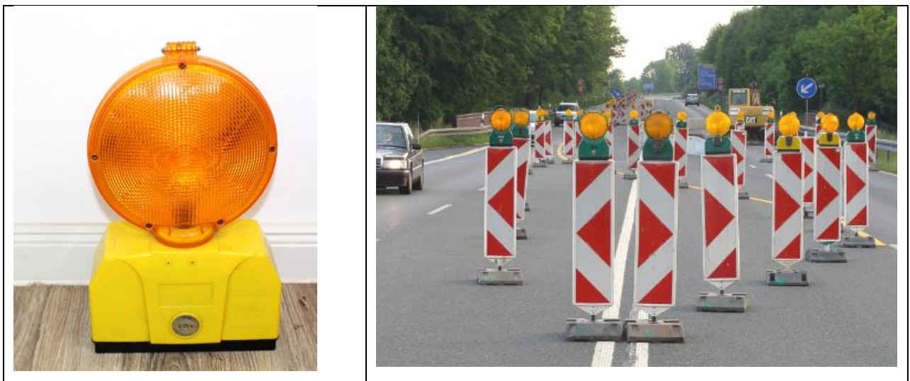
Abb. 1: Baustellenlampen mit und ohne zugehörige Warnbake
